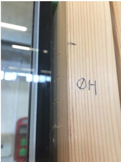
Figur 3 Ridser i træet ved montering (generelt)
