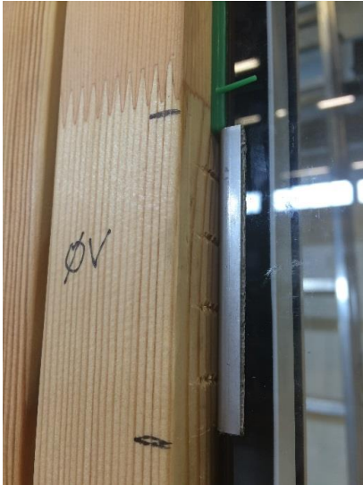
Figur 2 Ridser i træet ved montering (generelt)
