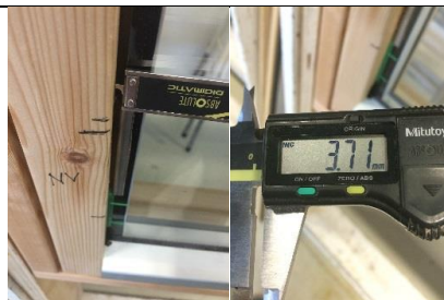
Afstand fra glas til ramme målt ved placering af glaslås (NV)
