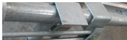
Fig. 2 Dobbelt forankring med rørfastgørelse på overliggerens lodrette søjle. Brug en rørfastgørelse samt en dobbelt fast kobling 48/34 mm (varenr: 18SFF105-3448)
