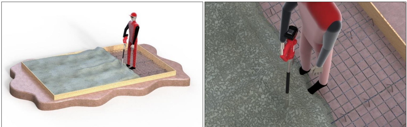
Figuur 6: Werkwijze tijdens het beton verdichten.
